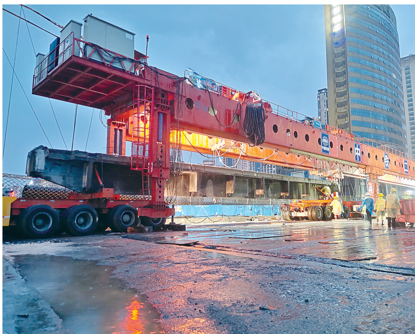
新华桥首片T梁被拆除吊离。株洲日报·掌上株洲记者/廖明摄
