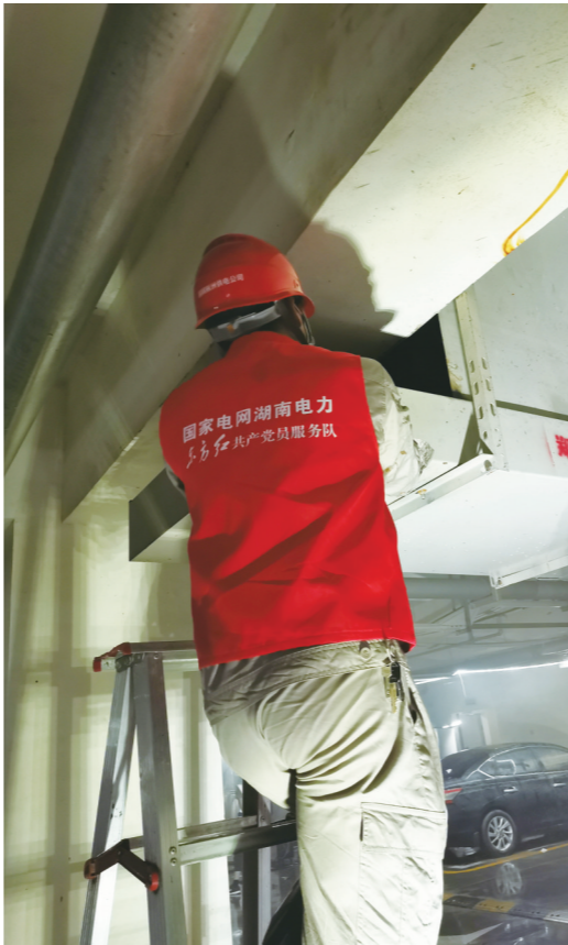
队员们正在郑州大学第一附属医院地下车库进行抢修。受访者供图
