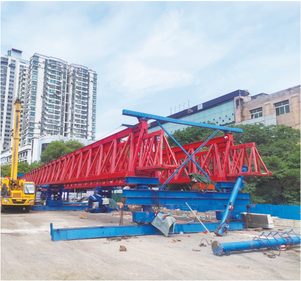
新华桥西头,完成组装的架桥机准备到位。 株洲日报·掌上株洲记者/廖明 摄
