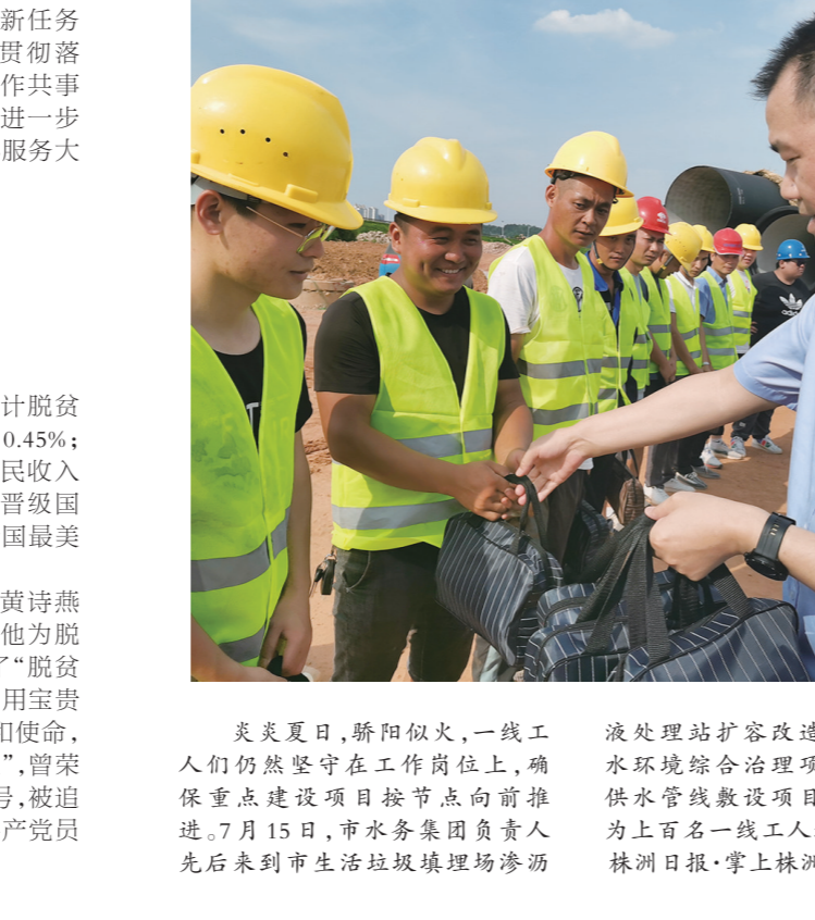
炎炎烈日,骄阳似火,一线工人们仍然坚守在工作岗位上,确保重点建设项目按节点向前推进。7月15日,市水务集团负责人先后来到市生活垃圾填埋场渗沥
