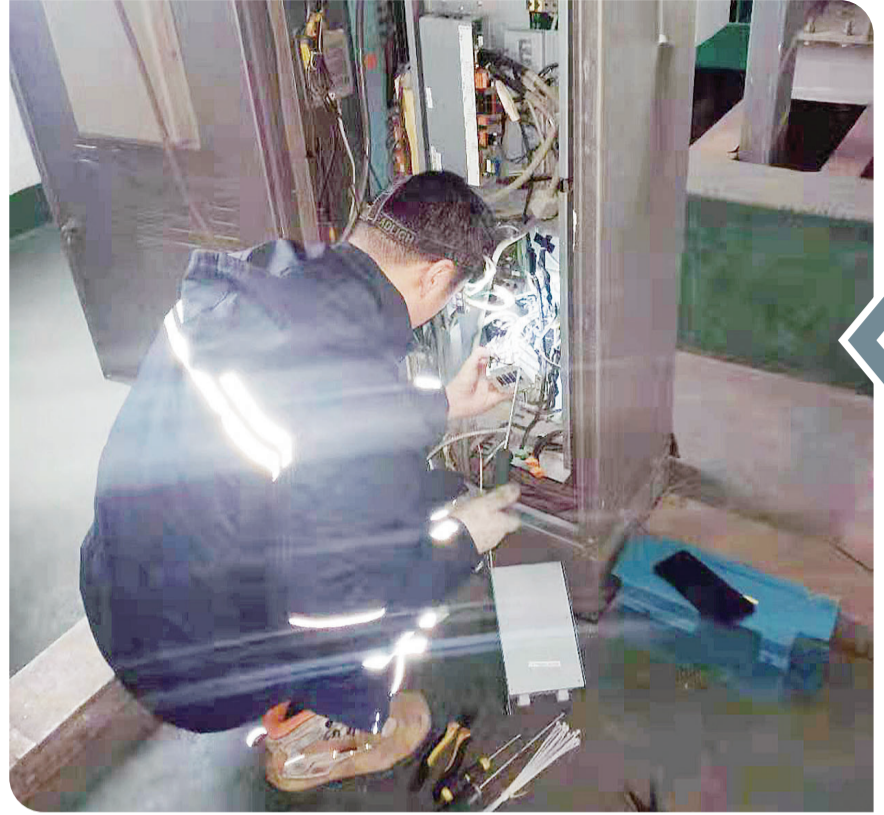
株洲某小区内,维修人员正在修理电梯。 吴楚/摄
