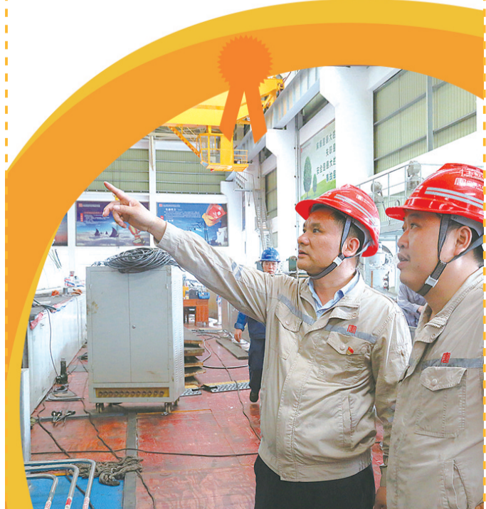
龙维智(左)在1号机汽轮机检修现场开展“四不两直”检查。 受访者供图
