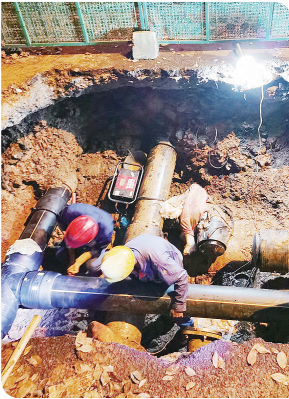
夜间施工依然闷热,汗水湿透了大家的工装。
