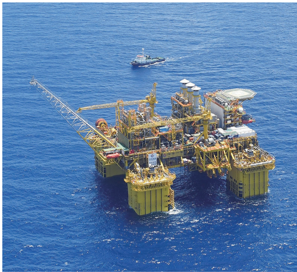
海南陵水海域拍摄的“深海一号”大气田(5月12日摄)。新华社记者 蒲晓旭 摄
