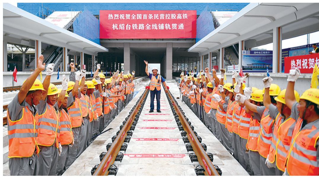
6月22日,中铁十一局的施工人员在杭绍台铁路温岭站施工现场庆祝铺轨贯通。新华社记者 黄宗治 摄
