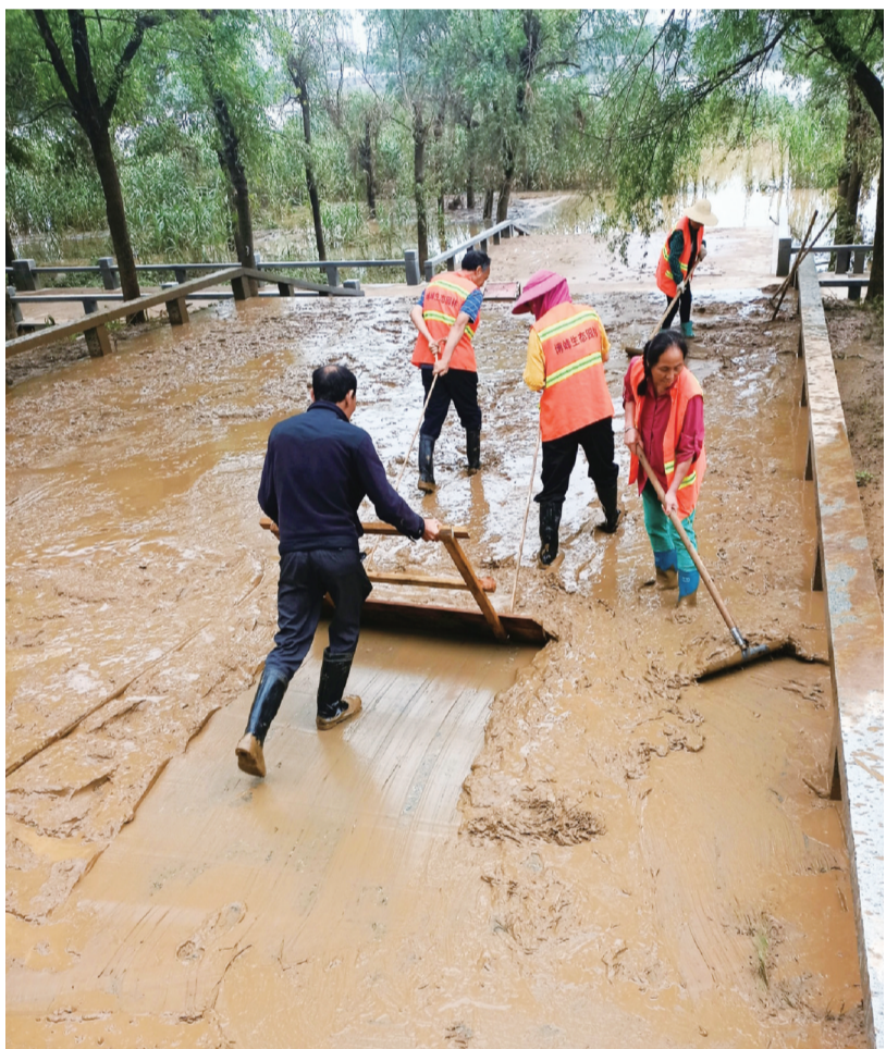
工作人员在湘江风光带现场清淤作业。翁艳恒 摄
