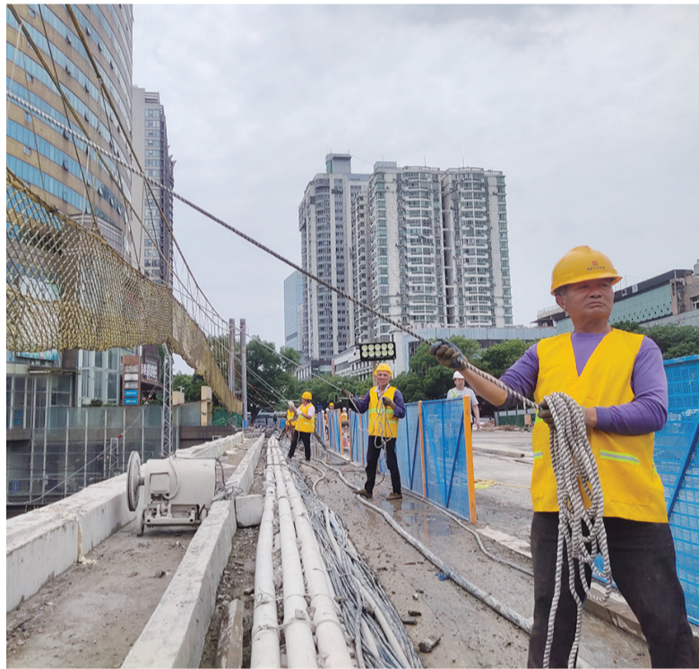
正在拉升中的“索桥”。株洲日报·掌上株洲记者/廖明 摄
