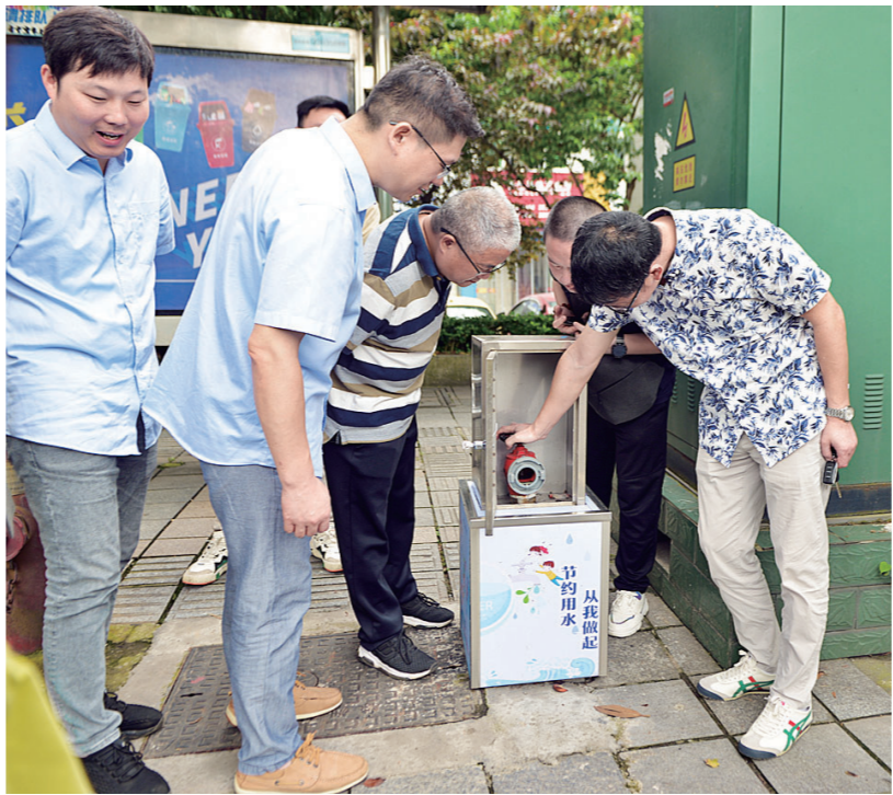
环卫绿化专用取水点。 株洲日报·掌上株洲记者/易蓉 供图
