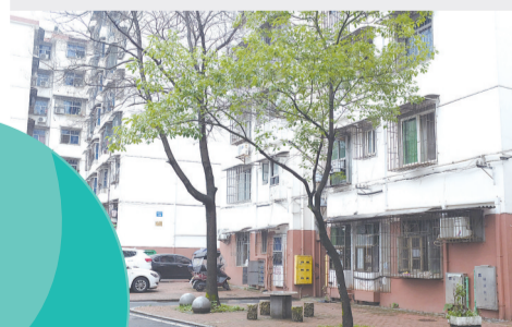
重建排水系统,进行雨污分流,改造后的铁路小区焕然一新。黄欣雨 摄
