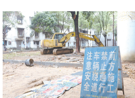
正在进行老旧小区提质改造工程的天元区金锦花园。黄欣雨 摄
