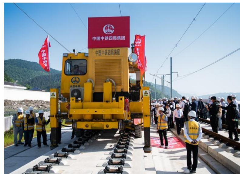
WPZ-500型无砟轨道智能铺轨机组正在作业。受访者 供图
