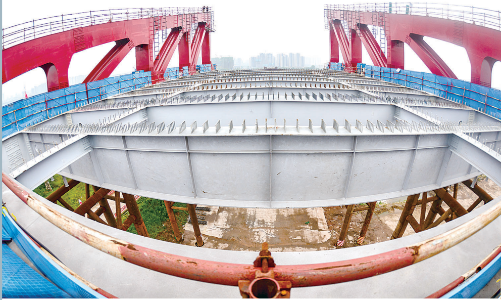
清水塘大桥施工现场。刘震 摄
