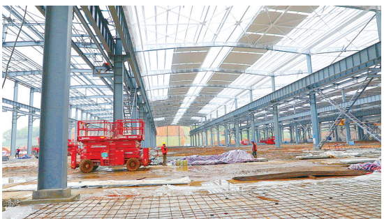
石峰区三一石油装备项目一期工程施工现场。廖成 摄
