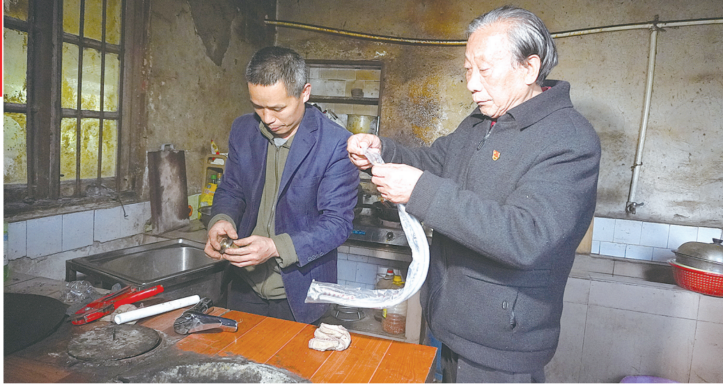
微心愿。李钰摄 老党员为帮扶对象安装洗菜盆下水管,完成
