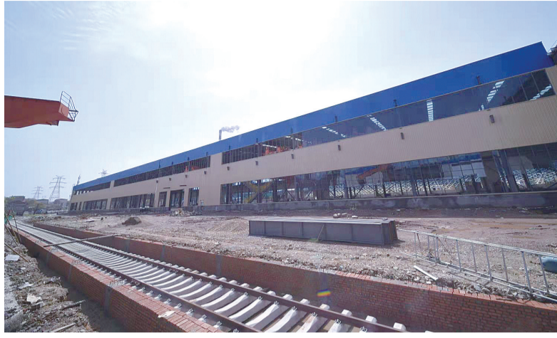
石峰区轨道交通先进制造业系列项目现场。通讯员 供图
