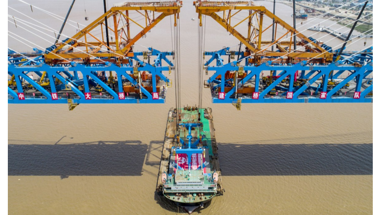
4月17日,在杭绍台铁路建设施工现场,随着最后一段钢梁吊装完成,杭绍台铁路控制性工程椒江
