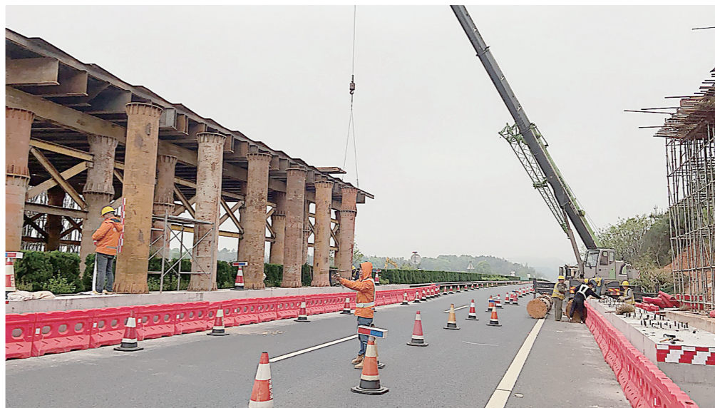
跨高速门洞架搭设已完成。 易蓉 陈德满/摄
