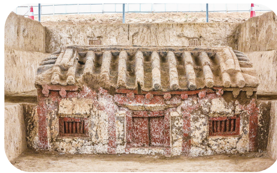
陕西西安少陵原十六国大墓第二土雕建筑南面(资料照片)。
