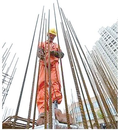
建筑工人正在作业。张康平 供图
