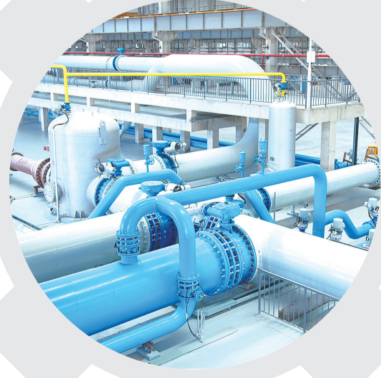
东方水谷水力实验室外景企业供图
