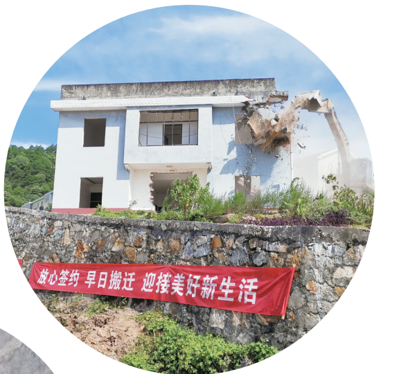
▲西环线项目房屋拆除
