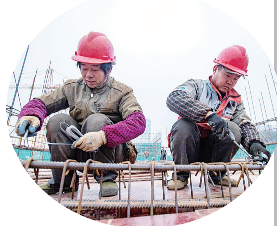
天元区项目建设现场。(资料图)记者 张媛/摄
