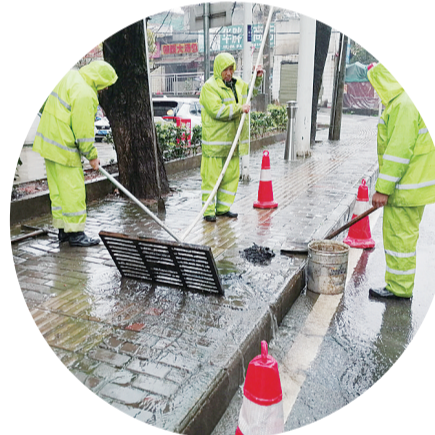
石峰区市政维护服务中心工作人员雨中清淤。株洲日报·掌上株洲记者/寻慧蓉 摄
