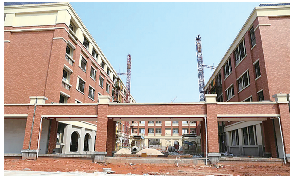
▲建设中的长沙一中株洲实验学校 通讯员供图
