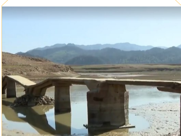
重新露出水面的石桥。
