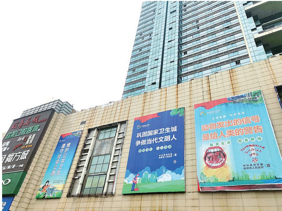
▲通过月度考核评价,多部门协力拆除了架设在商场屋顶的广告牌 记者 戴凜 摄
