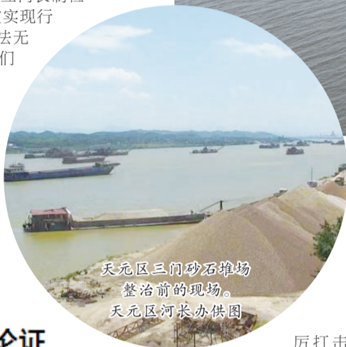
天元区三门砂石堆场整治后的现场。天元区河长办供图
