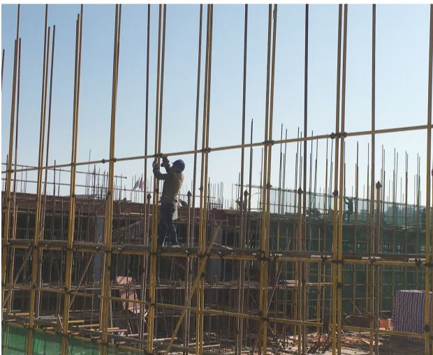
施工人员在厂房钢架上绑扎钢筋。刘毅摄
