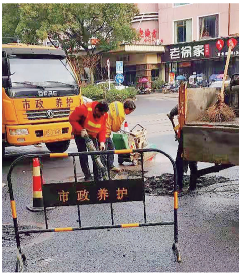
▲市政队员应急修缮路面坑洞 通讯员供图
