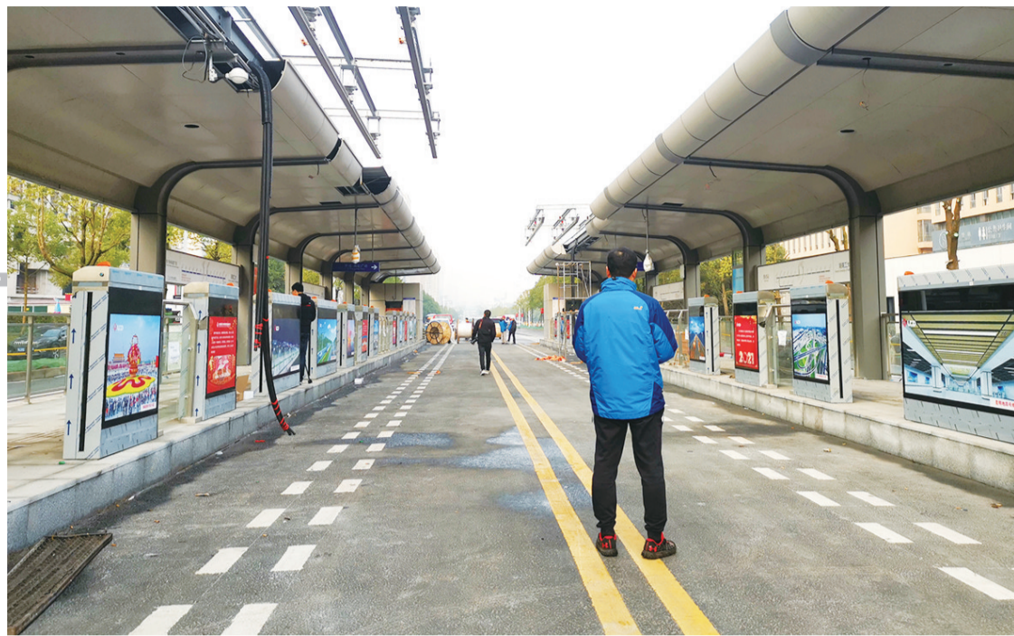
▲站台雨棚上的“天线”,就是智轨列车的充电装置
