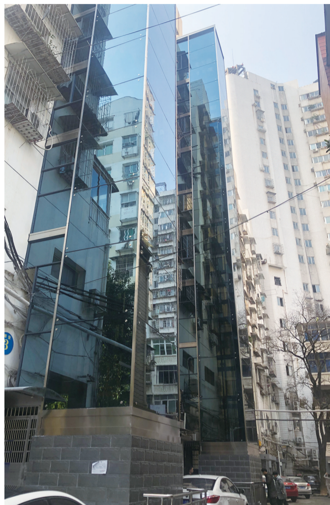
▲湘安小区加装的电梯 记者 周蒿 摄
