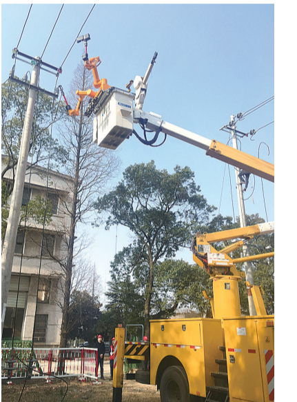
▲带电作业机器人在高压线上开展模拟任务 记者 刘玺 摄
