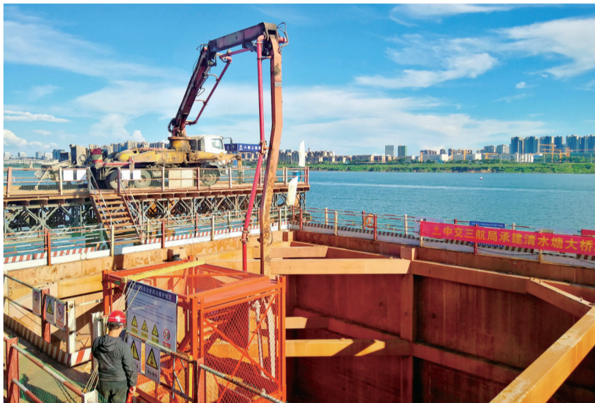
▲2020年8月20日—21日,中交三航局承建清水塘大桥22#主墩承台首次混凝土浇筑现场 首席记者 李卉 摄
