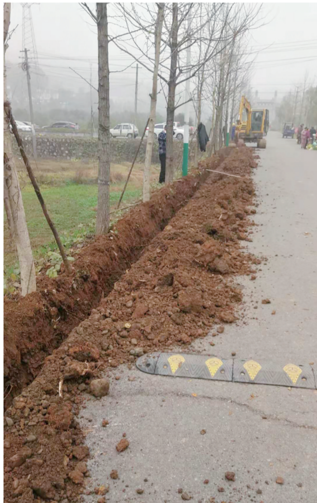
▲石峰区九郎山村铺设自来水管解决村民用水问题 通讯员供图
