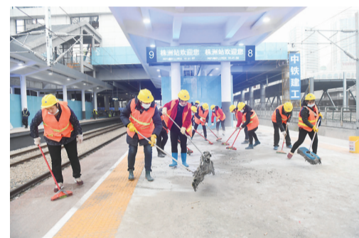
▲1月25日,地板铺设完后,工人正抓紧清扫现场
