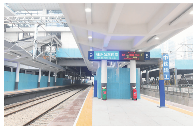
▲城际株洲站站台
