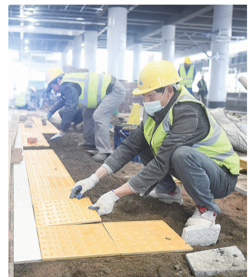
▲1月25日,站台施工现场,工人正在安装盲道地砖
