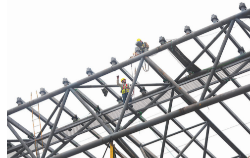
▲1月25日,东站房建设现场,工人正在安装钢桁架
