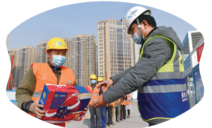
1月26日，在西安市东三义安置小区建设项目，中建三局西北公司工作人员向就地过年的工友发放慰问品。
