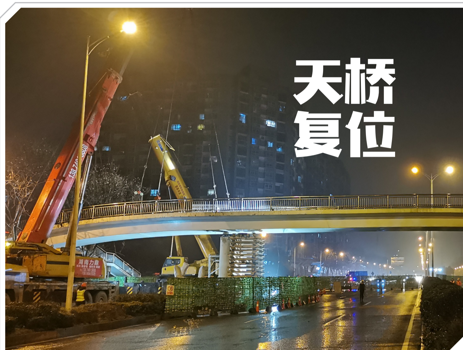
▲城管市政部门对东环线外国语学校附近人行天桥实施整体吊装复位,此前该桥因被车撞发生位移 全媒体记者 任远 通讯员 朱熠 摄
