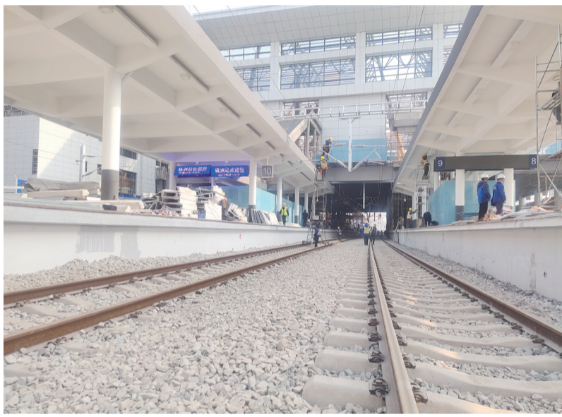
长株潭城际铁路株洲站施工现场。廖明/摄
