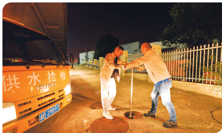
▲深夜,水务铁军供水抢修现场。
