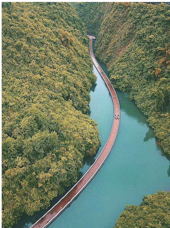
▲狮子关水上栈道
