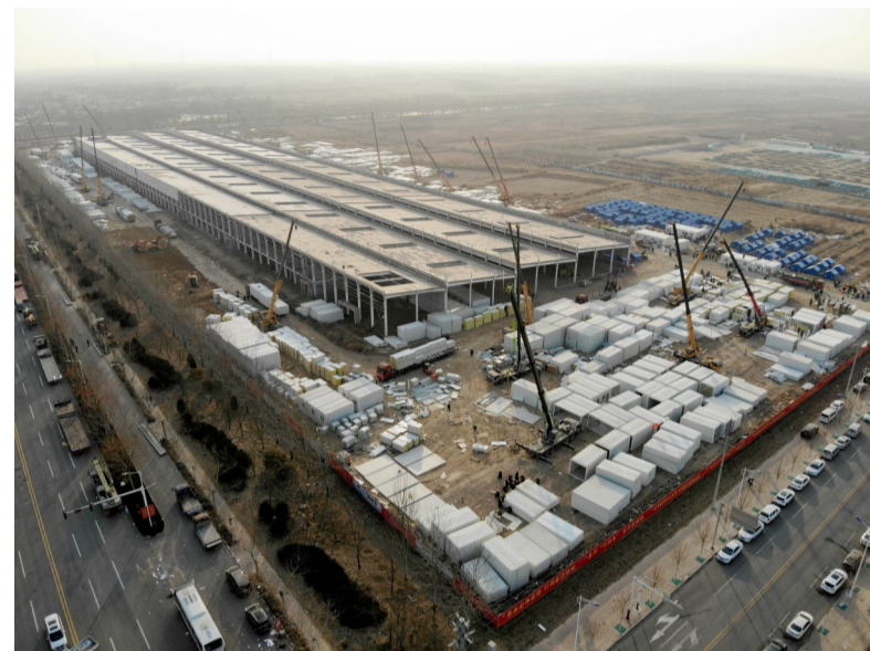
▲1月19日拍摄的位于河北南宫经济开发区的隔离场所项目建设现场(无人机照片)
