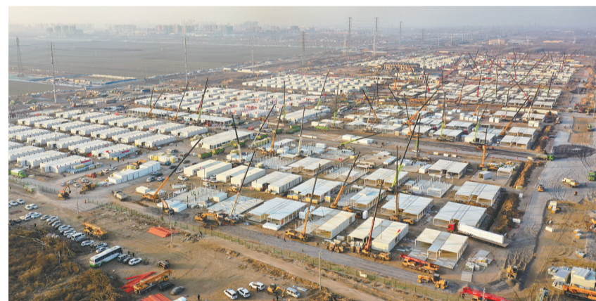
1月18日拍摄的石家庄黄庄公寓隔离场所项目工地(无人机照片)。 日前,石家庄黄庄公寓隔离场所项目集房屋主体结构拼装陆陆续续完工。黄庄公寓隔离场所位于河北石家庄市正定县与藁城区交界处黄庄村南,总占地面积510亩,用于安置新冠肺炎密切接触者和次密切接触者等人员。 新华社发
