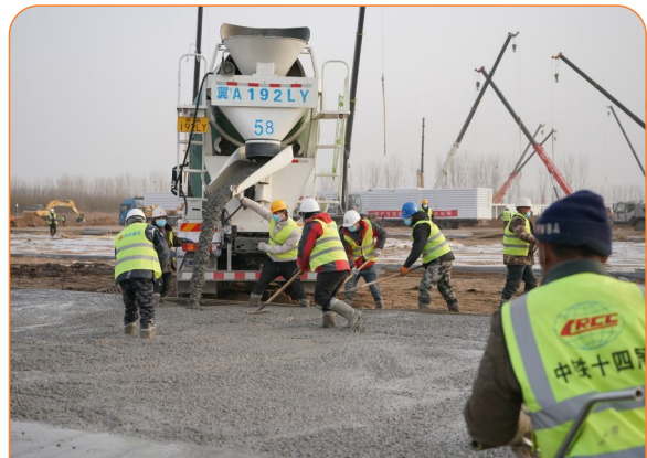
1月15日,工人在石家庄黄庄公寓隔离场所项目工地硬化集成房屋地面。新华社记者 杨世光 摄
