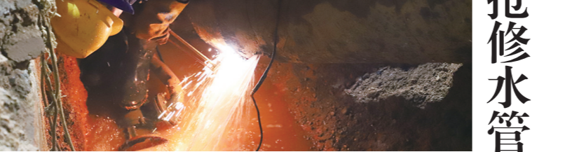
图为水管抢修施工中。 通讯员/张家诚 摄
