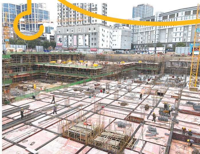
株洲意法时尚中心项目建设现场 受访者供图
