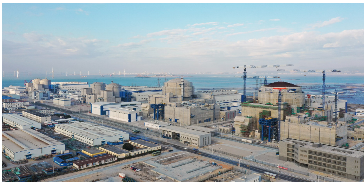
1月4日拍摄的福清核电全景图(无人机照片)。1月11日,“华龙一号”示范工程——中核集团福清核电6号机组完成冷态性能试验。
