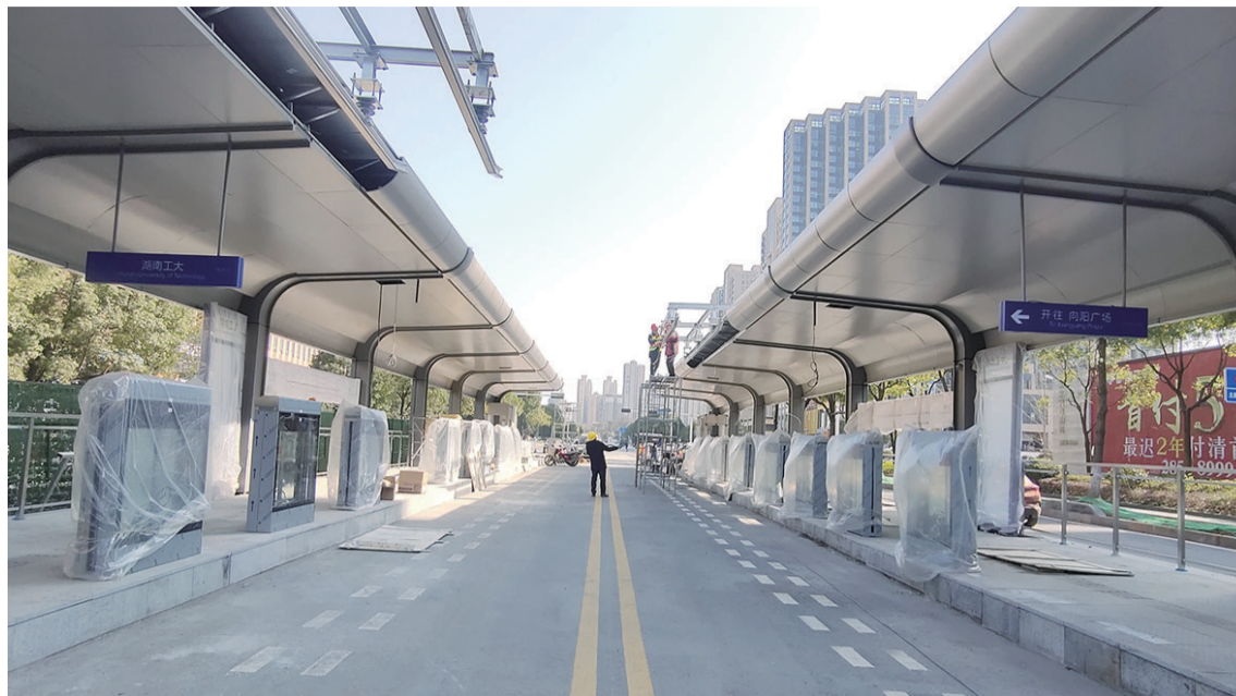
已基本成型的智轨湖南工大站,工作人员正在安装充电桩。廖明 摄
