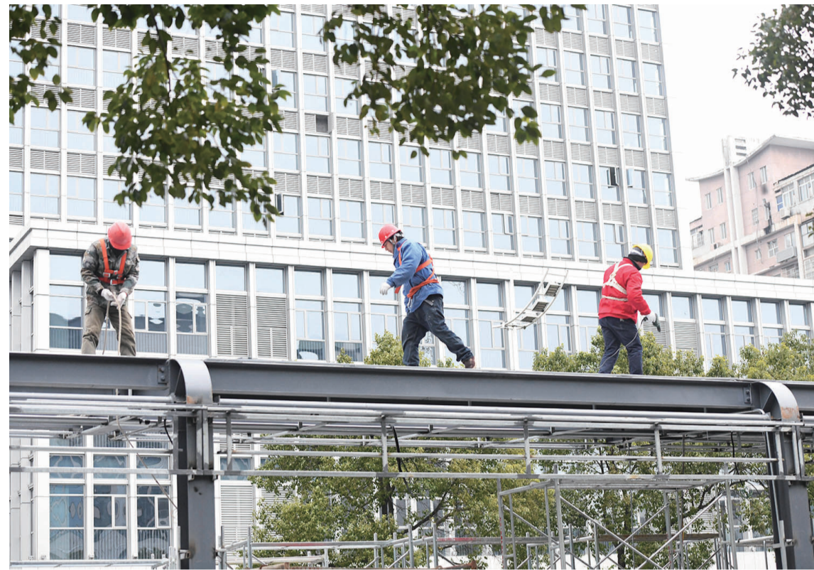
▲这几天天气暖和,阳光下的智轨车站正在施工中 记者 谢慧 摄
