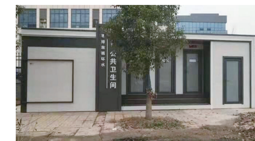
▲金山新城区域内,新增的零排放循环水公共卫生间 通讯员供图
